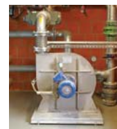
Die Anlage erzeugt 6500 Kubikmeter Methangas am Tag.
