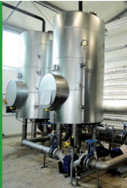
← Über unseren patentierten Kreis-Biogass-Dissolver (li.) und in der Hygienisierung (re.) werden die Rohstoffe zerkleinert und gereinigt.
